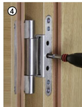
4 Türblatt ausrichten und Klemmschrauben **C** fest anziehen.
