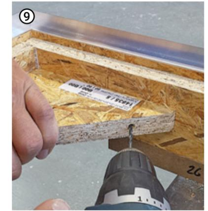
9 Aussteifungsdreiecke oben positionieren, vorbohren ...
