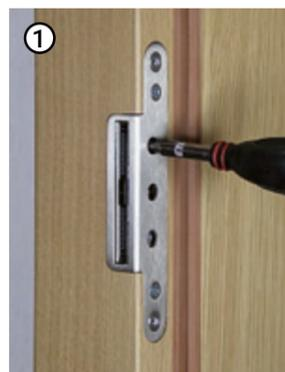
1 Klemmschrauben **C** leicht lösen
