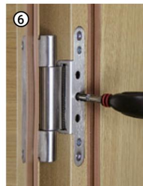
6 Türe 90° öffnen und gut unterkeilen um ein Absacken zu vermeiden. Klemmschrauben **C** leicht lösen und Türe mit Hilfe von Distanzplättchen oder Keilen in Position bringen. Klemmschrauben **C** wieder fest anziehen.
