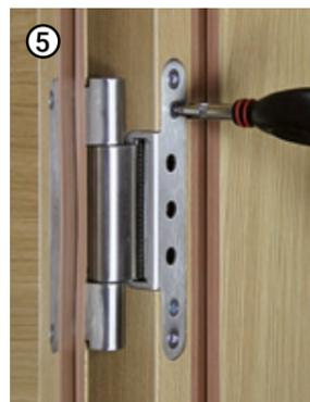
5 Durch gleichmäßiges und abwechselndes drehen der Schrauben **B** die Seitenverstellung vornehmen. **ACHTUNG** darauf achten, dass sich die Aufnahmeelemente nicht verspannen.
